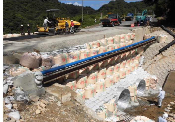
H30. 8. 18 仮復旧完成
