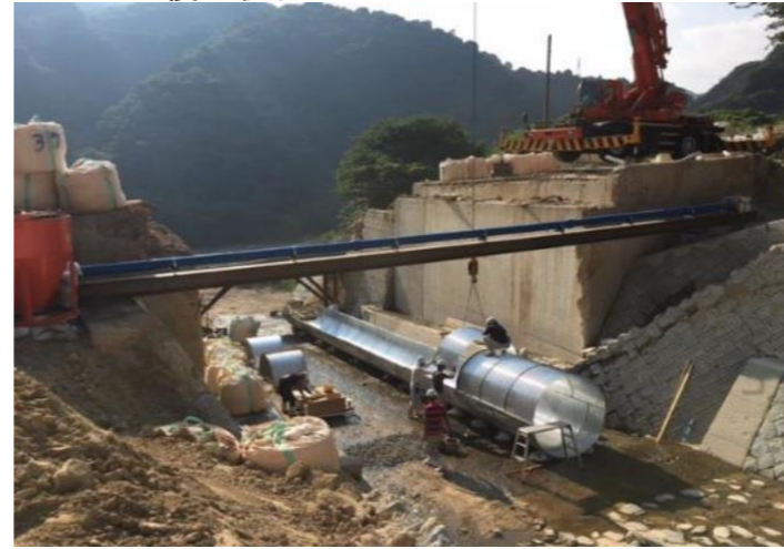
H30. 8. 6 復旧状況
