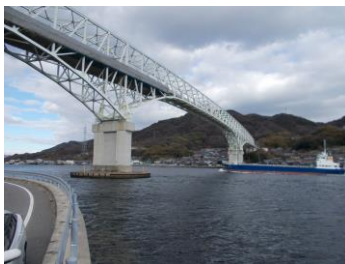
【早瀬大橋（国道487号）】
