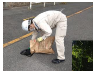
【道路の補修作業】
