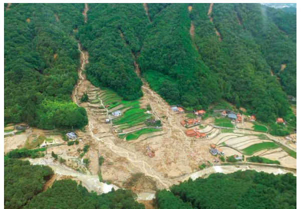
【平成30年7月豪雨で被災した安浦町市原地区】
