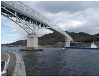
【早瀬大橋（国道487号）】
