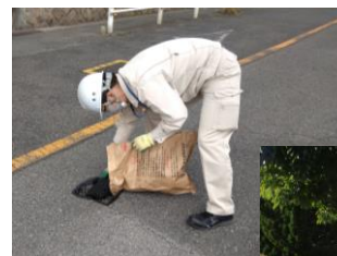
【道路の補修作業】
