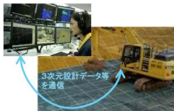
【ICT 建設機械による自動施工】
