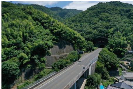
【広島呉道路（クリアライン）】
