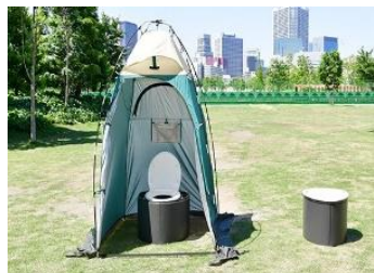
マンホールトイレ
