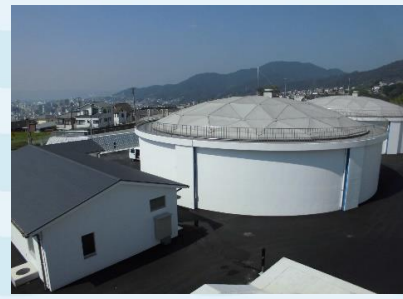
平原低区配水池 平原高区ポンプ所
