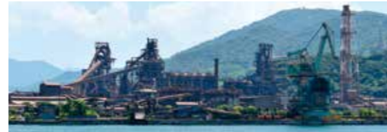
9月に全設備を休止した日本製鉄瀬戸内製鉄所呉地区
