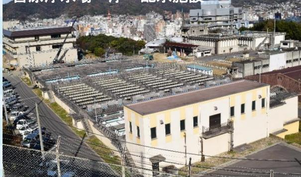
◀平成25年4月に完成した本市唯一の浄水場で、浄水能力は82,000m<sup>3</sup>/日です。階層式になっていて、下部には配水池が整備されています。
