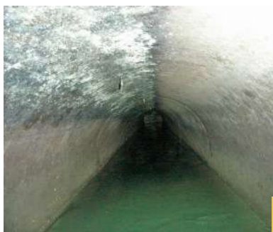
工事前の下水道管
