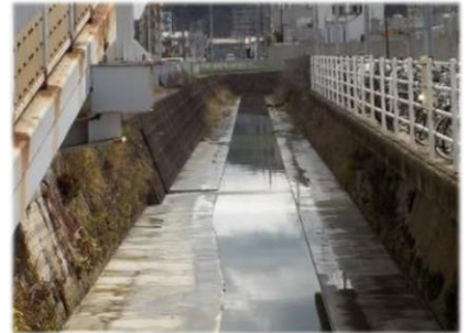
広雨水1号幹線（整備後）
