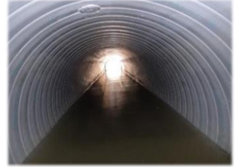
更生工事完了後の下水道管
