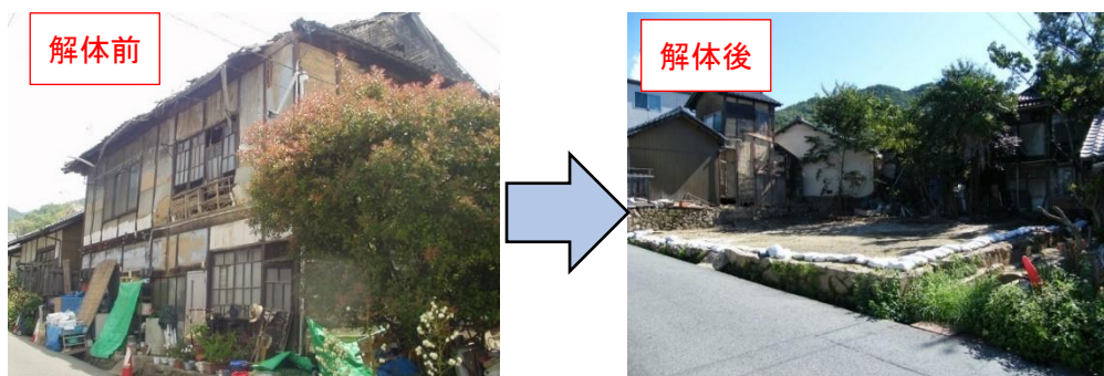
【呉市危険建物除却促進事業による解体(事例)】
