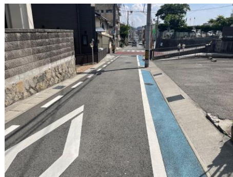
カラー舗装による空間確保
