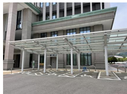
障害者用駐車区画
