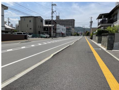
バリアフリー化された市道
