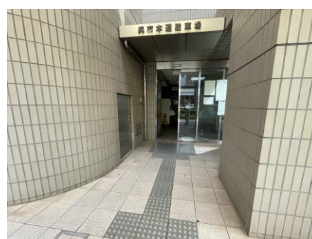
視覚障害者誘導用ブロック
