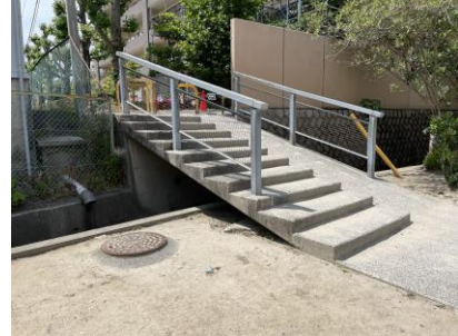
スロープ補修予定箇所（勾配調整）
