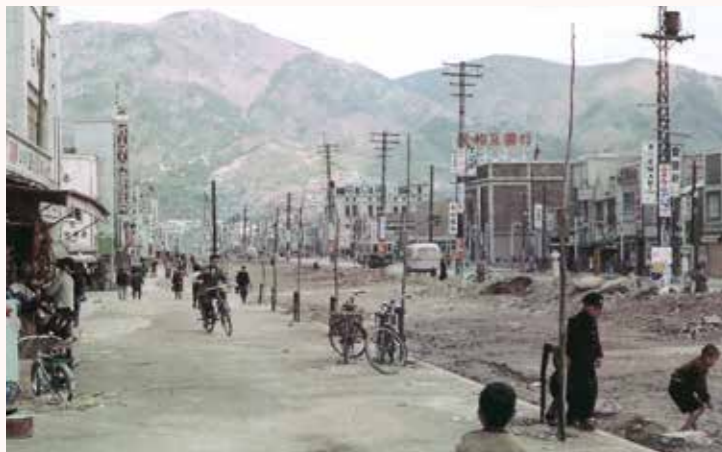
道路拡張工事が進む本通 (本通2丁目付近) 昭和28年 (F.Bryant氏提供)
