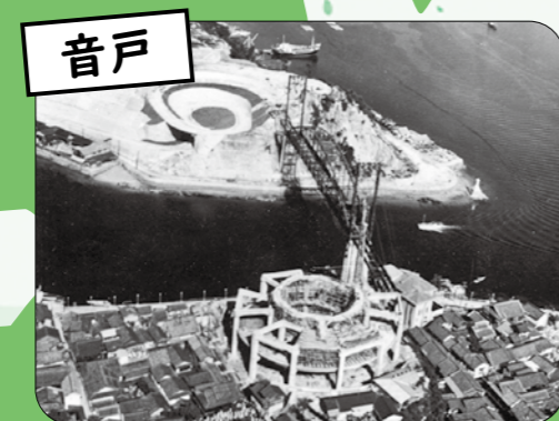
螺旋状の高架橋が特徴的な音戸大橋
