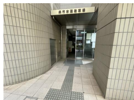
視覚障害者誘導用ブロック
