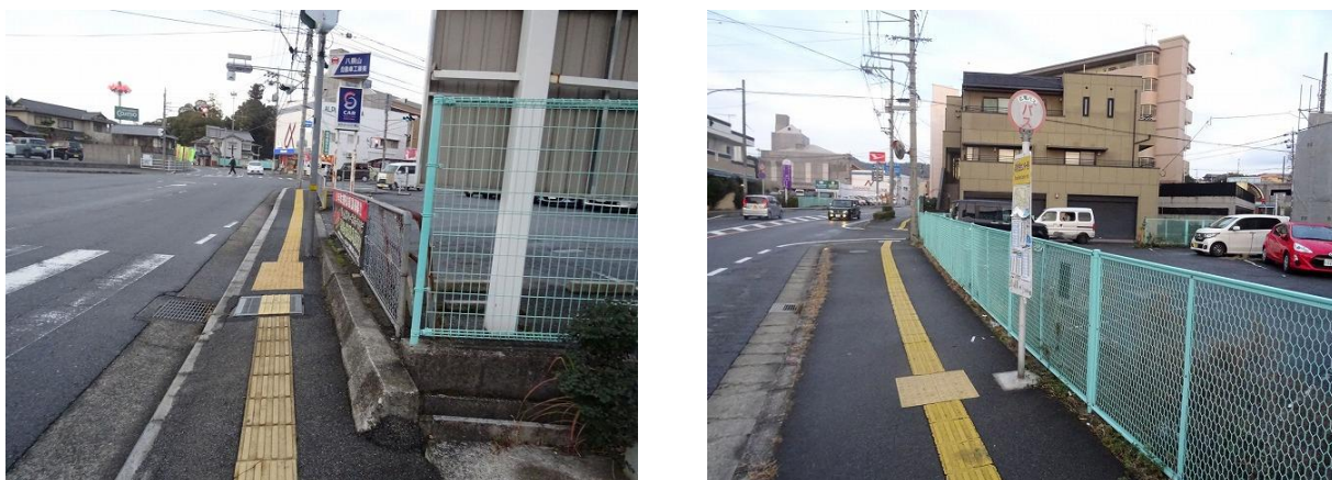
図 6 5 昭和市民センター周辺地区の状況
