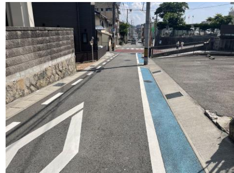
カラー舗装による空間確保
