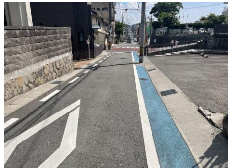
カラー舗装による空間確保
