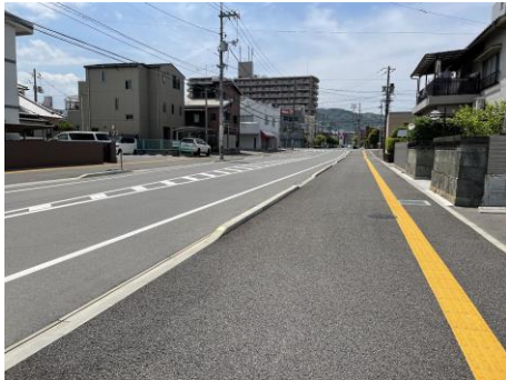
バリアフリー化された市道
