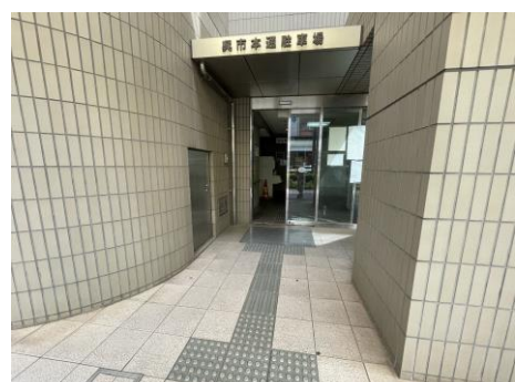
視覚障害者誘導用ブロック
