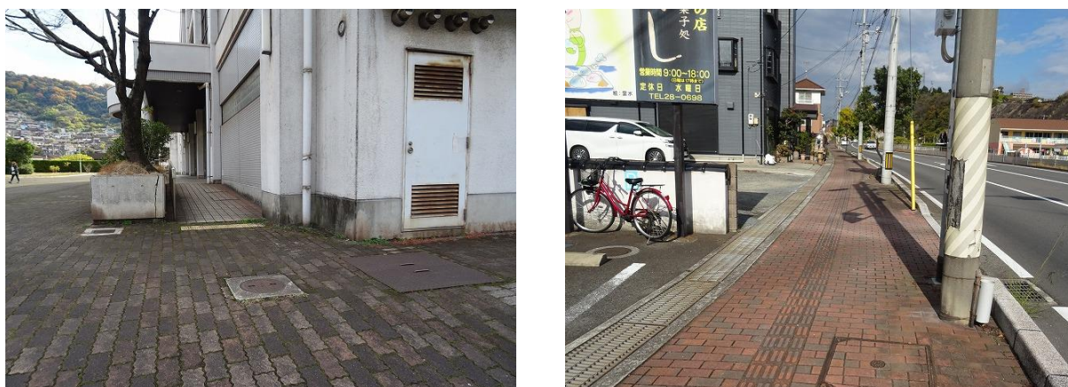
図 6 6 鍋棧橋周辺地区の状況
