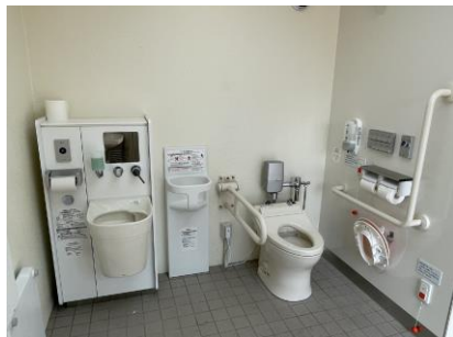
公園内の障害者用トイレ
