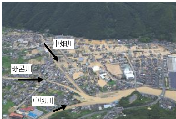
【安浦地区の浸水被害（平成30年7月7日）】
