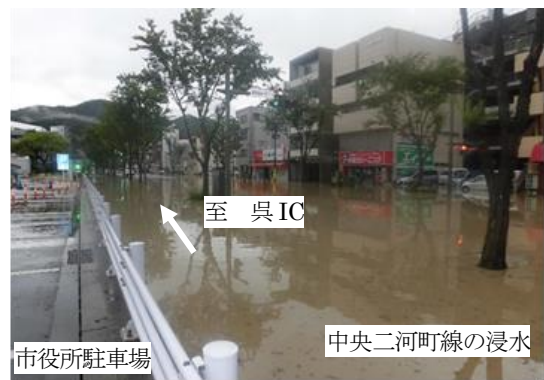
【中央地区（市役所周辺）の浸水被害（平成30年7月7日）】
