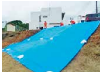
ビニール張り工法
