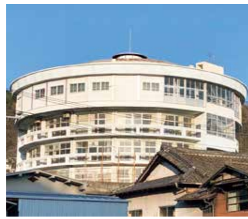
呉市に唯一現存する港町小学校の円形校舎
