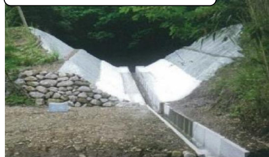
防災工事（廃止） 利用しなくなったため池の廃止工事
