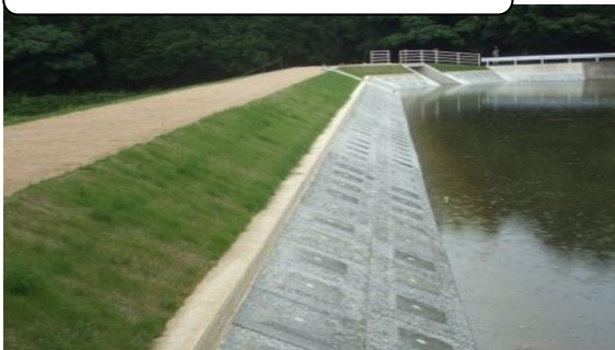
防災工事（補強） 機能維持のための補強対策（補強工事）
