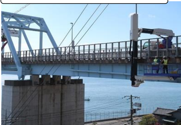
農道施設の長寿命化・強靱化（定期点検）
