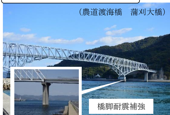
農道施設の長寿命化・強靱化（整備工事）
