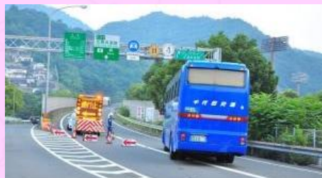
平成30年7月豪雨 広島呉道路災害時BRT
