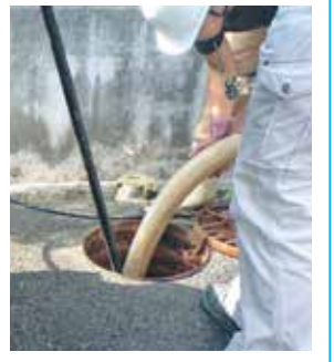
詰まった下水管の洗浄作業
