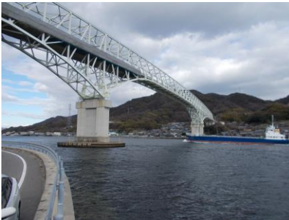
【早瀬大橋（国道487号）】
