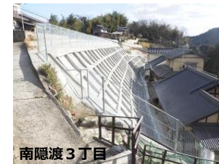
【整備された急傾斜地崩壊対策施設】
