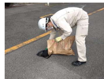
【道路の補修作業】
