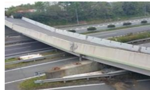
【熊本地震で倒壊した橋りょう】
