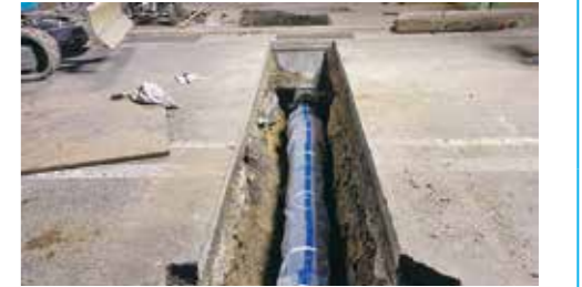
水道管取り替え工事の様子
