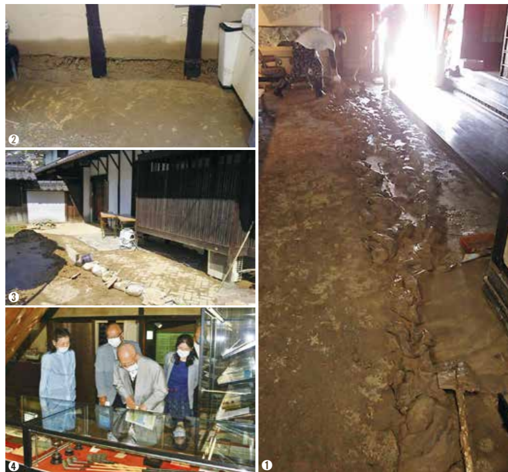
①土間に溜まった泥②床に広がる泥と壊れた土壁、浸水の跡③母屋外の様子④復旧し展示が再開した母屋
