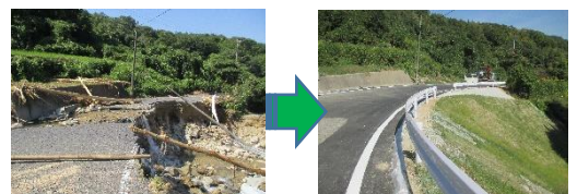
市道郷原大積線の復旧:(左)着手前,(右)着手後
