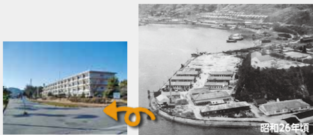
海上保安大学校 旧呉海軍工廠火工部 ☆幹部海上保安官を養成する日本で唯一の大学校です。
