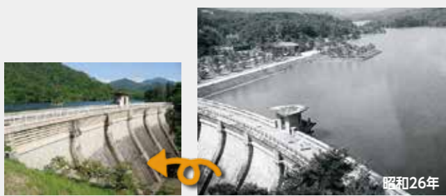
本庄水源地堰堤水道施設 旧呉軍港水道本庄水源地 ☆日本遺産構成文化財の堰堤は今もその姿を残しています。
