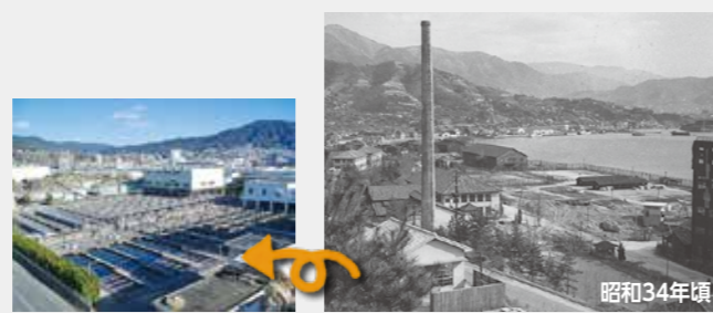
新宮浄化センター 旧第11海軍航空廠新宮兵器部工場 ☆昭和44年に新宮下水処理場として供用開始しました。
