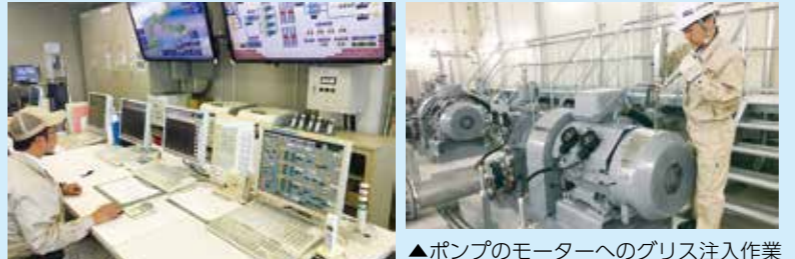
▲ポンプのモーターへのグリス注入作業
