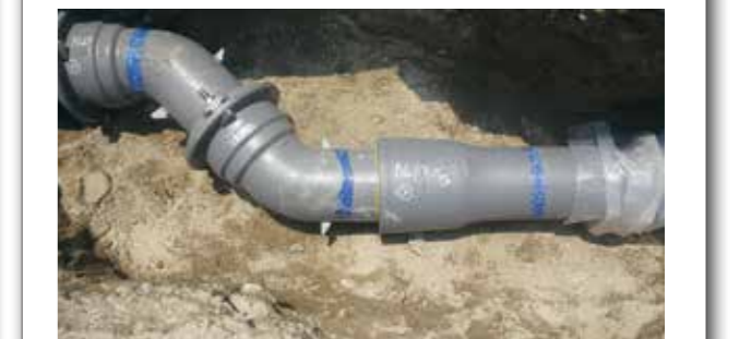
▲耐震管の布設状況(ダクタイル鋳鉄管)
