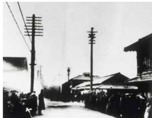
平原浄水場通水・最初の水圧試験 (大正6年)
