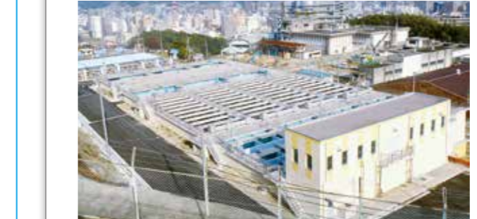
▲耐震化した宮原浄水場の浄水施設
