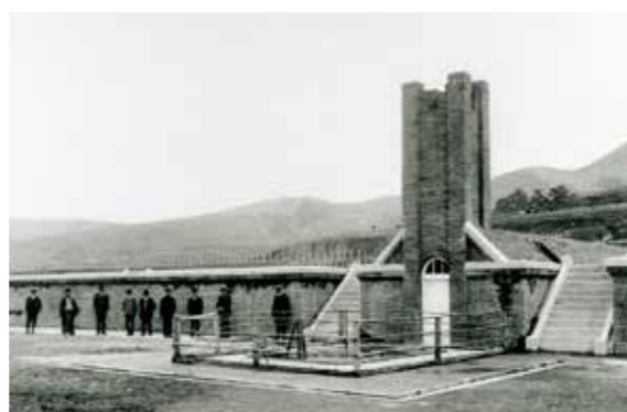
▲完成した平原浄水場低区配水池(大正6年12月)
