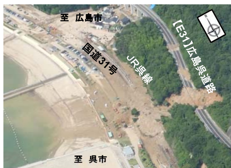
国道31号被災状況
