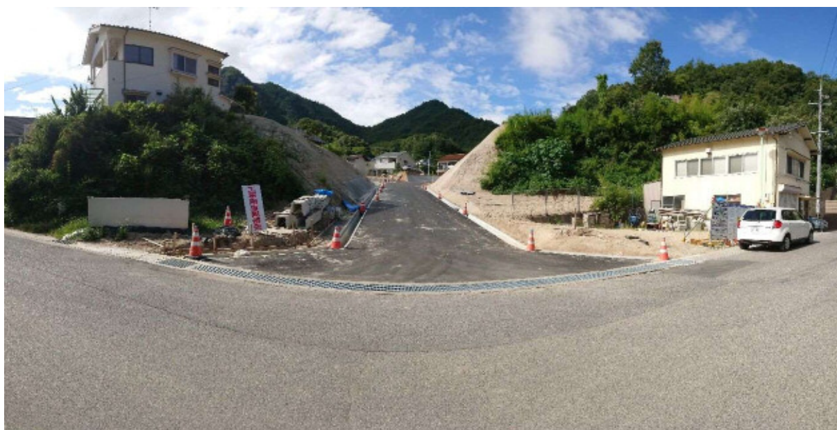
背戸ノ川上流にて整備中の砂防ダムの工事用道路
