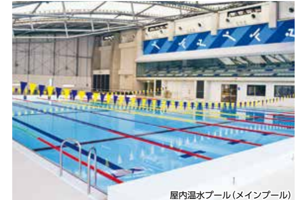
屋内温水プール(メインプール)
