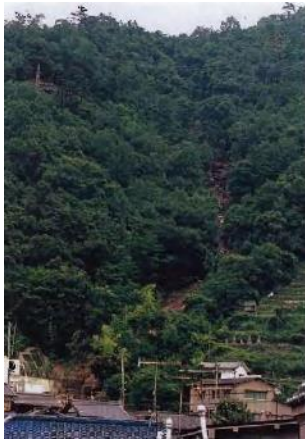
崩壊斜面全景
