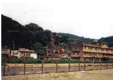
災害発生斜面の全景
