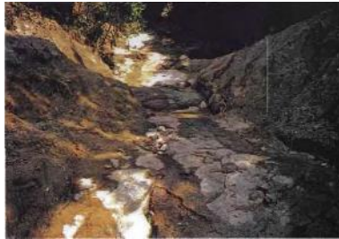
崩壊斜面(表土が流出したため露出した風化花崗岩)
