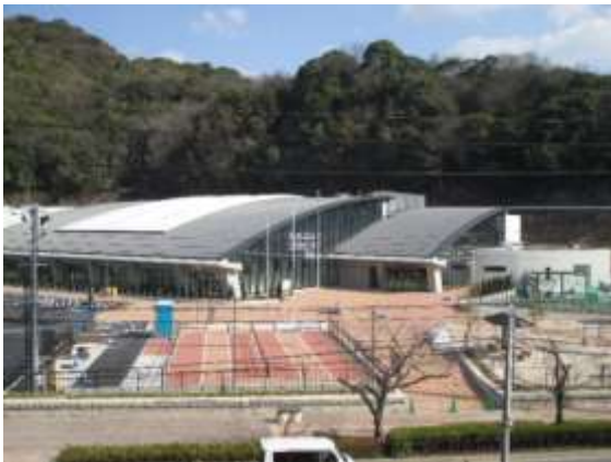
屋内 温水プール
