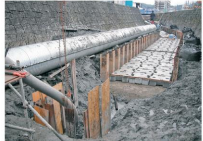
▲川底の勾配修正工事【広雨水1号幹線】
