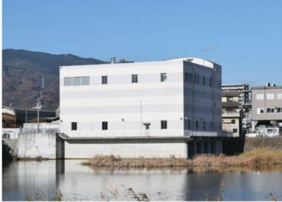
▲高潮時でも排水するための雨水ポンプ場 【名田雨水ポンプ場】
