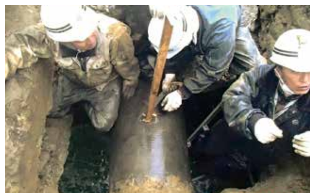
▲頼りない足場での作業、足下には川が見える
