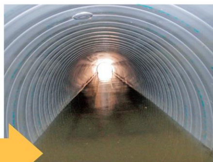
工事後の下水道管
