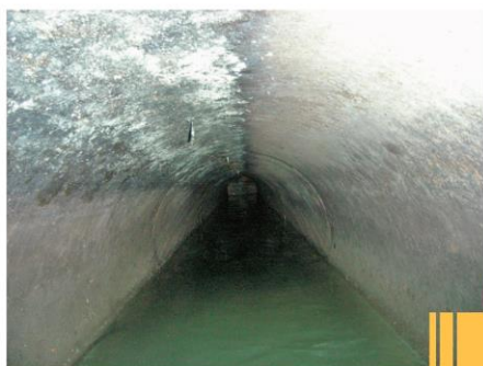
工事前の下水道管
